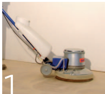
Boden schleifen.
