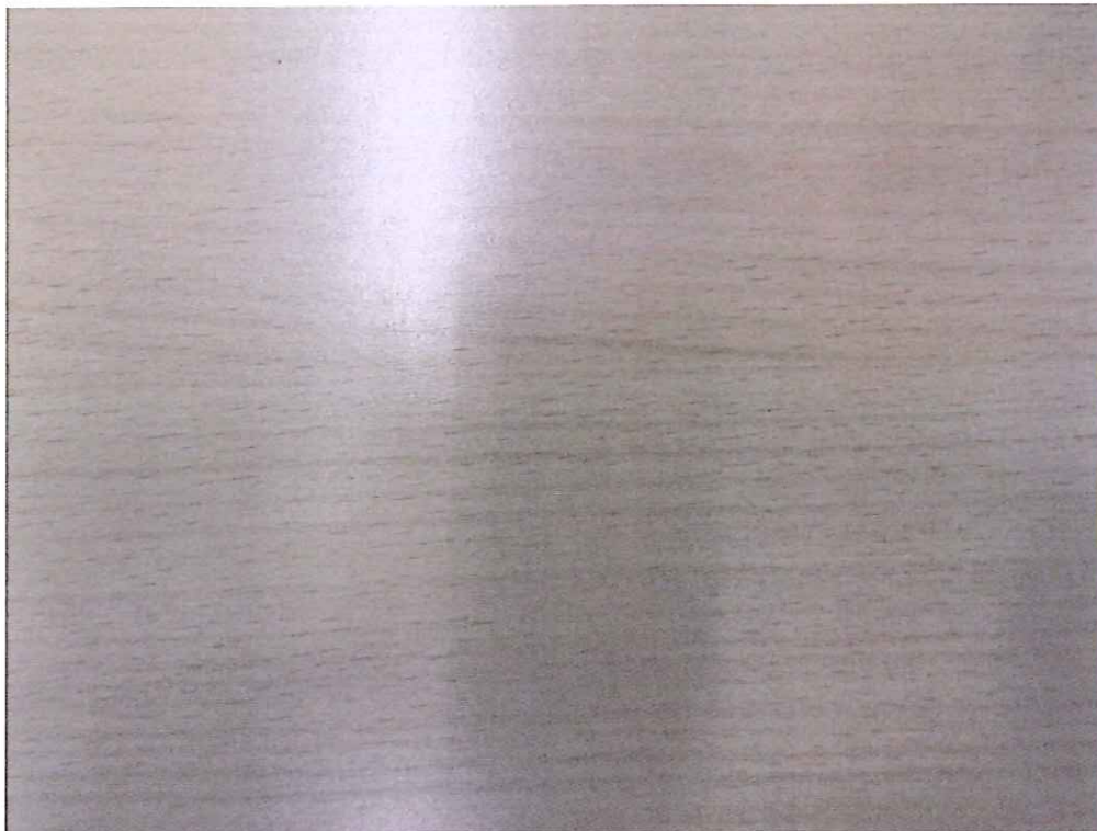
Struktur des Parkettbodens (Buche Furnier auf Spanplatte verlegt)
